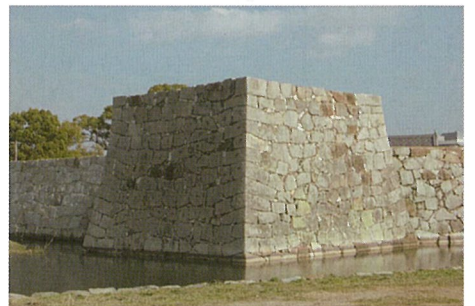
⑰北隅櫓台
