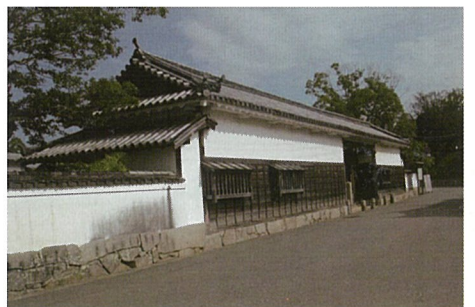
③⑫大石良雄宅跡長屋門
