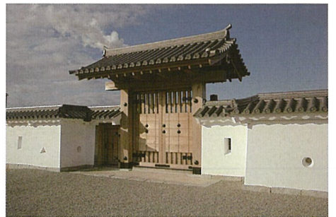
⑱西仕切門
