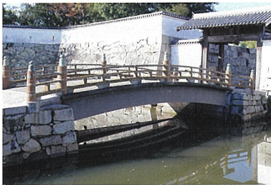
㉓大手門太鼓橋下の旧上水道管
