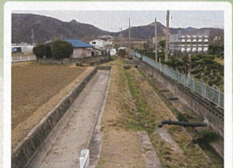
導水路のルートは一部が付け替えられています
