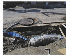
下水管の迂回措置
