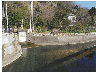
⑪山崎山東水余し樋
