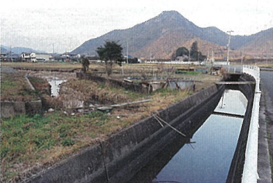
⑨導水路跡(右)と悪水路(左)の交差
