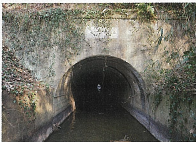
①切山隧道
