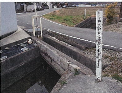
⑨導水路跡(下)と悪水路(上)の交差
