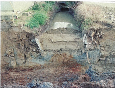
⑧導水路の発掘調査
