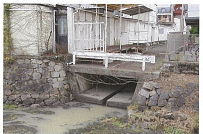
⑰余水排水溝
