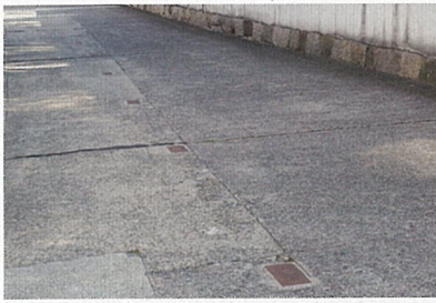
⑱レンガによる上水道ルート表示
