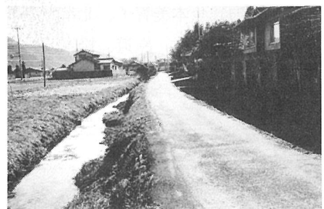
導水路 (右) と悪水路 (左)
