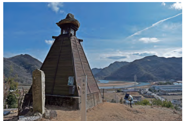
平成 30 (2018) 年に修理された舟灯台
