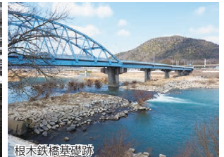
根木鉄橋基礎跡
