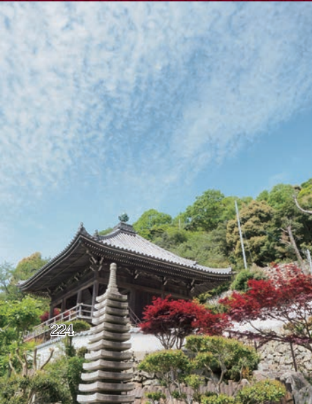
妙見寺観音堂（坂越） 宝珠山の山腹にある珍しい懸造建築。 市指定文化財。
