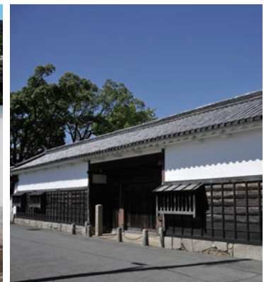
大石良雄宅跡長屋門 赤穂藩浅野家老の大石内蔵助良雄の屋敷は享保14（1729）年に焼失、長屋門のみが残された。
