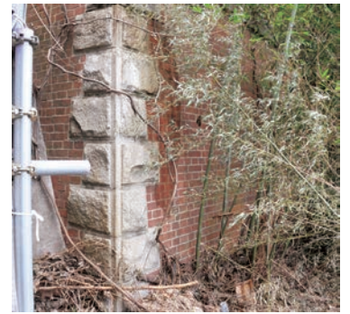
旧有年橋橋台
