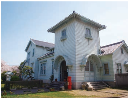
旧日本専売公社赤穂支局 兵庫県指定建造物。現在は赤穂市立民俗資料館となっている。
