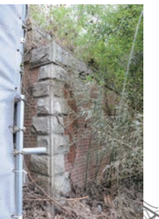
旧有年橋橋台
