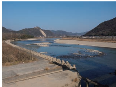
木津取水井堰跡
