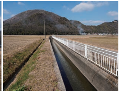
三ヶ村の樋跡
