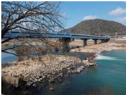
根木鉄橋基礎跡
