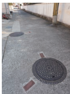
旧上水道保存区域
