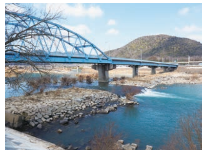
根木鉄橋基礎跡
