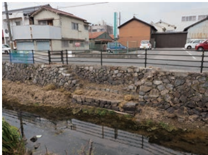
加里屋川護岸の雁木
