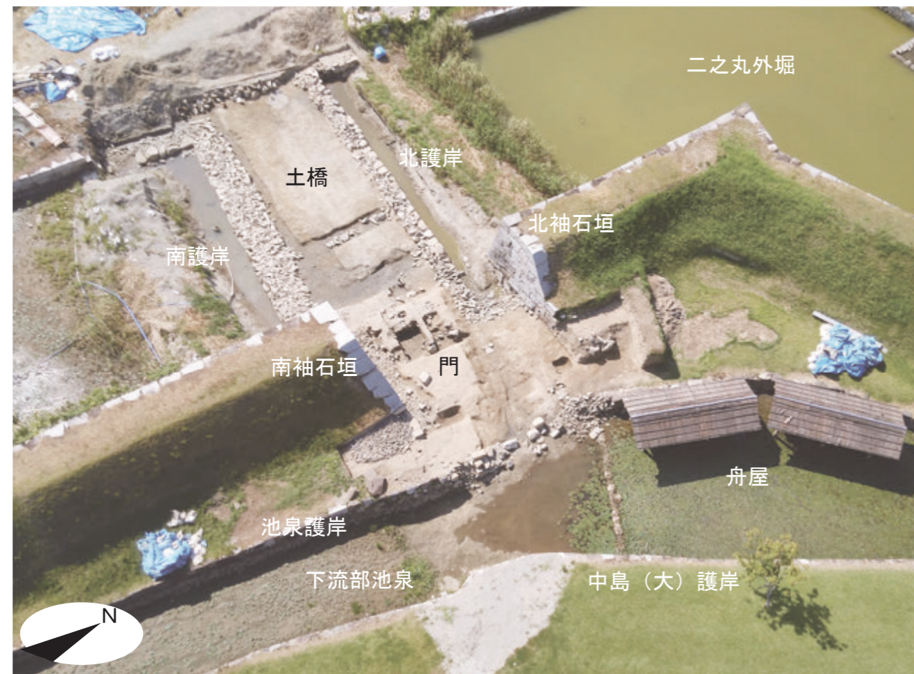
西中門跡 全景写真
